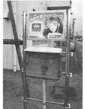
大原電業に設置された自動電気自動車充電コンセント
